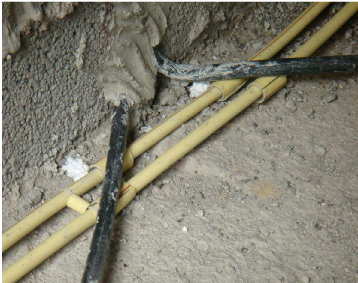
شکل ۲۴- اجرای غلاف مناسب
