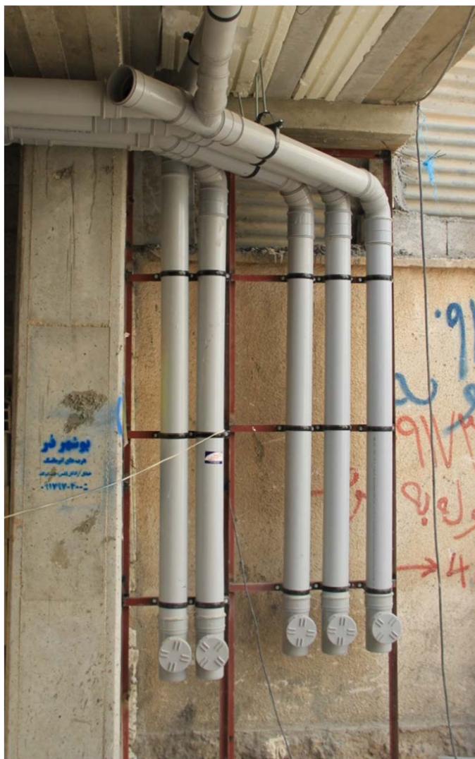
شکل ۲۰- اجرای صحیح دریچه بازدید
