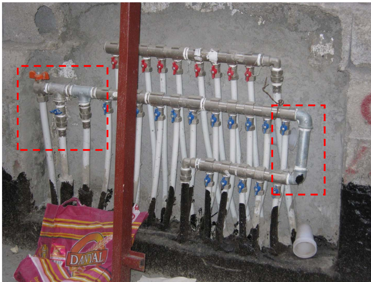
شکل ۱- استفاده از لوله و اتصالات غیر همجنس
