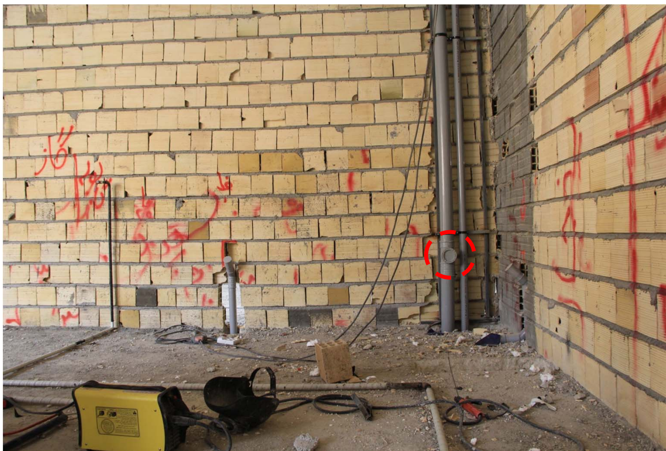
شکل ۱۹- اجرای دریچه بازدید در فضای آشپزخانه
