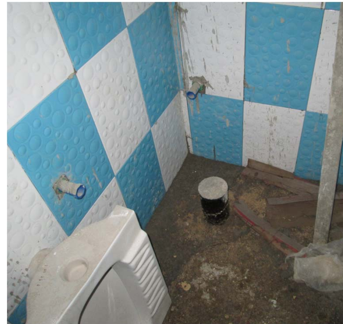
شکل ۲۲- عدم رعایت فاصله محور طولی از دیوارهای مجاور
