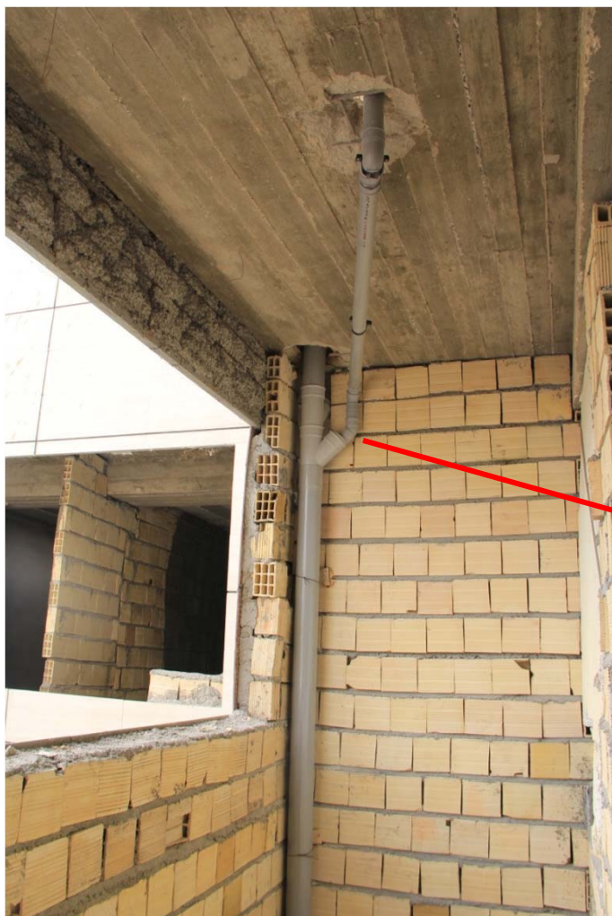
شکل ۳۱- استفاده از تبدیل نامناسب ۲ به ۵
