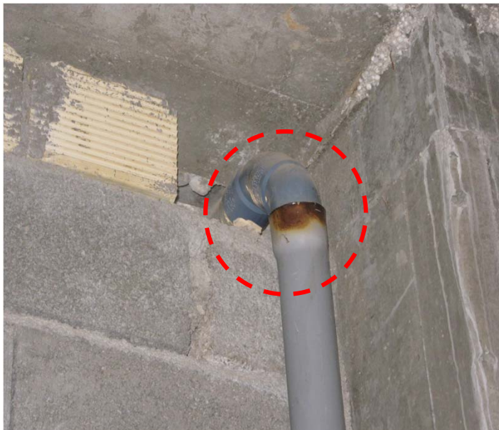
شکل ۱۳- سوختگی محل اتصال
