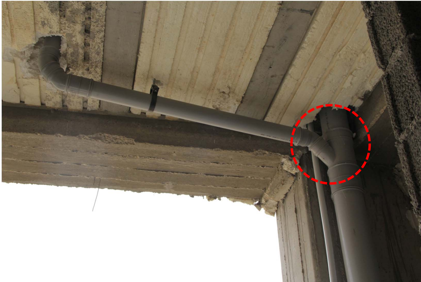
شکل ۳۲- استفاده صحیح از سه راهی تبدیل
