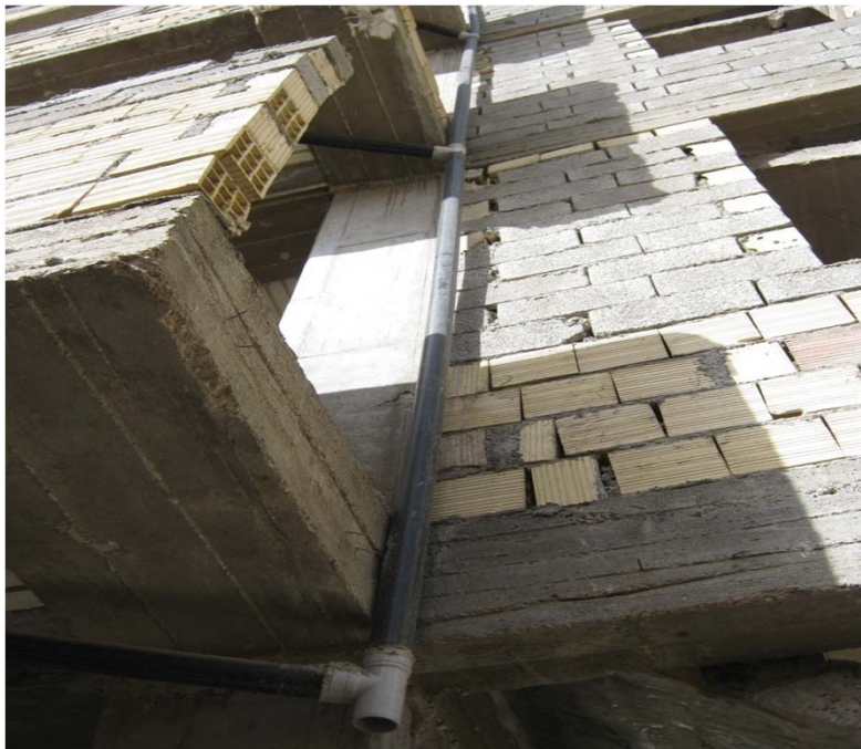
شکل ۱۰- استفاده نامناسب از اتصالات ۹۰ درجه
