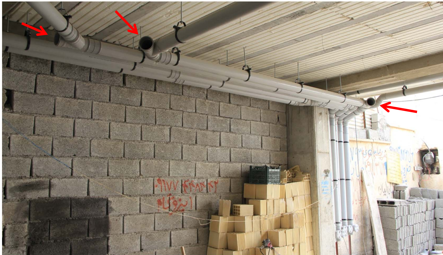
شکل ۲۱- اجرای صحیح دریچه بازدید
