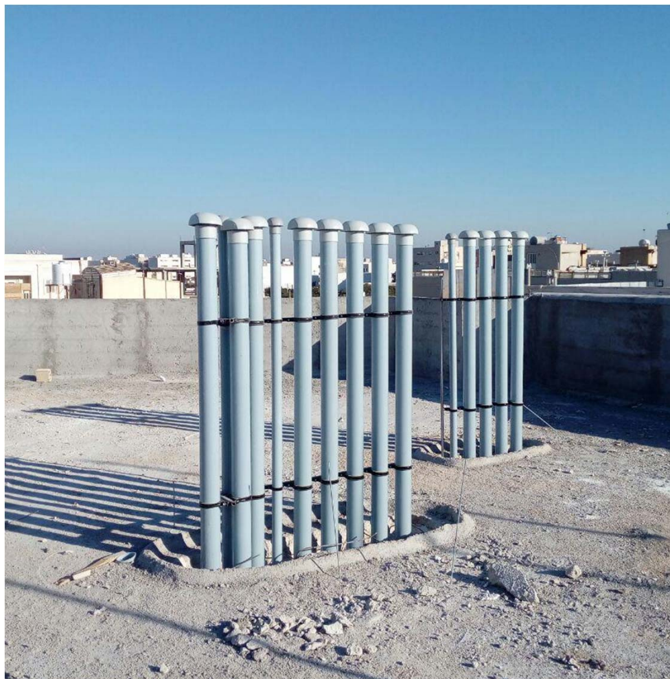
شکل ۳۸- استفاده از کلاهک مناسب بر روی رایزر هواکش در پشت بام
